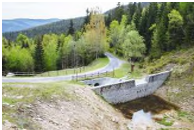
Fotografia 145. Opróżniona z zalęgającego rumoszu wysoko położona na zboczu góry zapora w Nadleśnictwie Świeradów. (archiwum CKPŚ).
