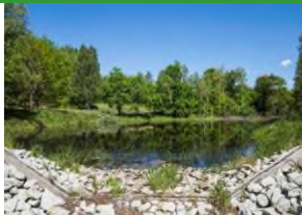
Fotografia 45. Prógi drewniane z umocnieniem kamiennym w Nadleśnictwie Okonek, fot. J. Smarczewski, 2023.
