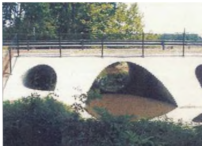
Fotografia 149. Przykłady wielootworowych przepustów z rezerwową przepustowością na wody powodziowe [Kosicki 2011].
