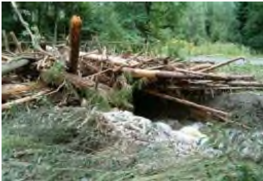
Fotografia 150. Rumosz niesiony wodą w czasie katastrofального wezbrania osadzony na moście (archiwum CKPŚ)
