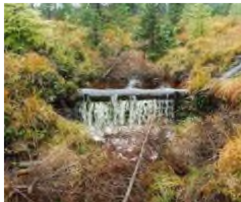
Fotografia 41. Próg drewniany na rowie odprowadzającym wodę z torfowisk po zboczu oraz rumosz drzewny wrzucany do rowu celem przyspieszenia zarastania w Nadleśnictwie Świeradów, 2010 (archiwum CKPŚ).
