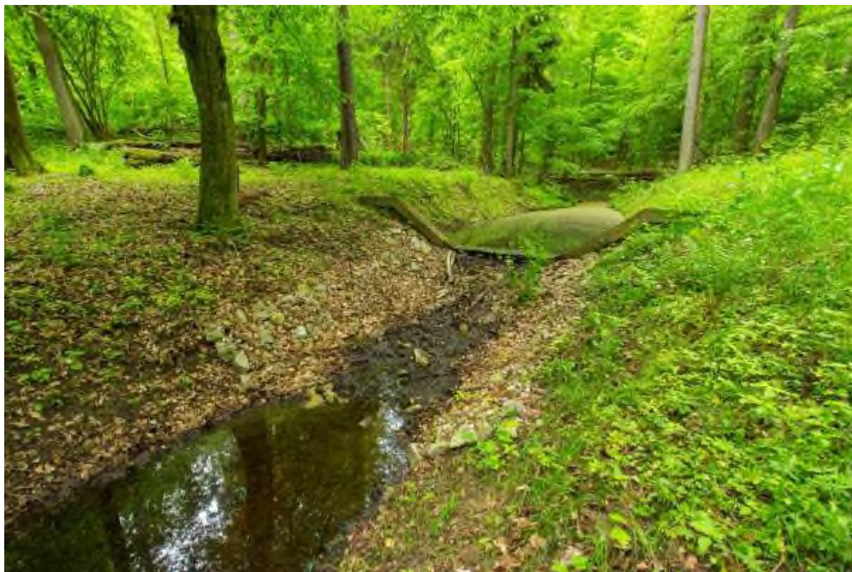
Fotografia 39. Piętrzenie stałe – ścianka szczelna podparta bystrzem w Nadleśnictwie Maskulińskie, 2015 (archiwum CKPŚ).
