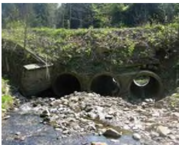
Fotografia 146. i Fotografia 147. Przebudowa przepustu na nowoczesną konstrukcję odporną na zatkanie rumoszem Nadleśnictwa Baligród (archiwum CKPŚ).
