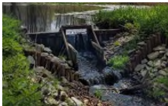
Fotografia 33. Wzmocnienia wykorzystane przy budowie zastawki w Nadleśnictwie Oława, fot. K. Jata, 2023.
