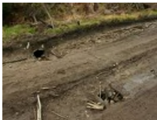
Fotografia 53. i Fotografia 54. Przypadkowo odkryty betonowy zbieracz sieci drenarskiej pod drogą na zdrenowanym w okresie przedwojennym zboczu, obecnie miejscowo porośniętym torfowcem (dawne uproduktywnienia terenu) w Nadleśnictwie Wałbrzych (archiwum CKPŚ).
