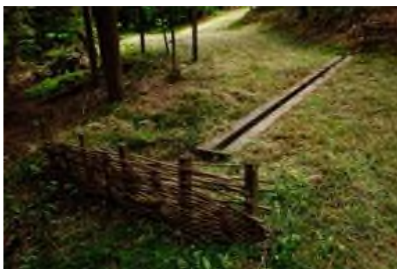
Fotografia 140. i Fotografia 141. Płotki faszynowe przeciwoerozyjne rozpraszające wodę na stok (archiwum CKPŚ).
