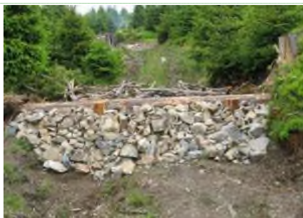
Fotografia 102. Przegroda drewniana wypełniona gałęziówką ubezpieczona narzutem kamiennym w Nadleśnictwie Łądek Zdrój (archiwum CKPŚ).
