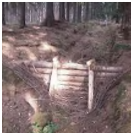
Fotografia 101. Przegrody drewniane wypełnione gałęziówką na szlakach zrywkowych w Nadleśnictwie Jugów (archiwum CKPŚ)
