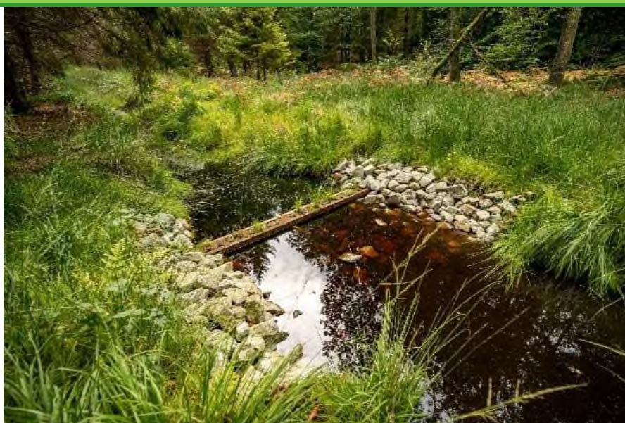
Fotografia 44. Próg ze ścianki szczelnej w Nadleśnictwie Polanów, Fot. J. Smarczewski 2021.
