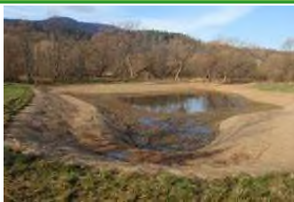
Fotografia 10. Zbiornik w trakcie realizacji w Nadleśnictwie Stuposiany, widoczne urozmaicenie dna. Brzegi zbiornika wyłożone są matą z włókien naturalnych, wspomagającą proces równomiernej sukcesji roślinnej (archiwum CKPŚ).
