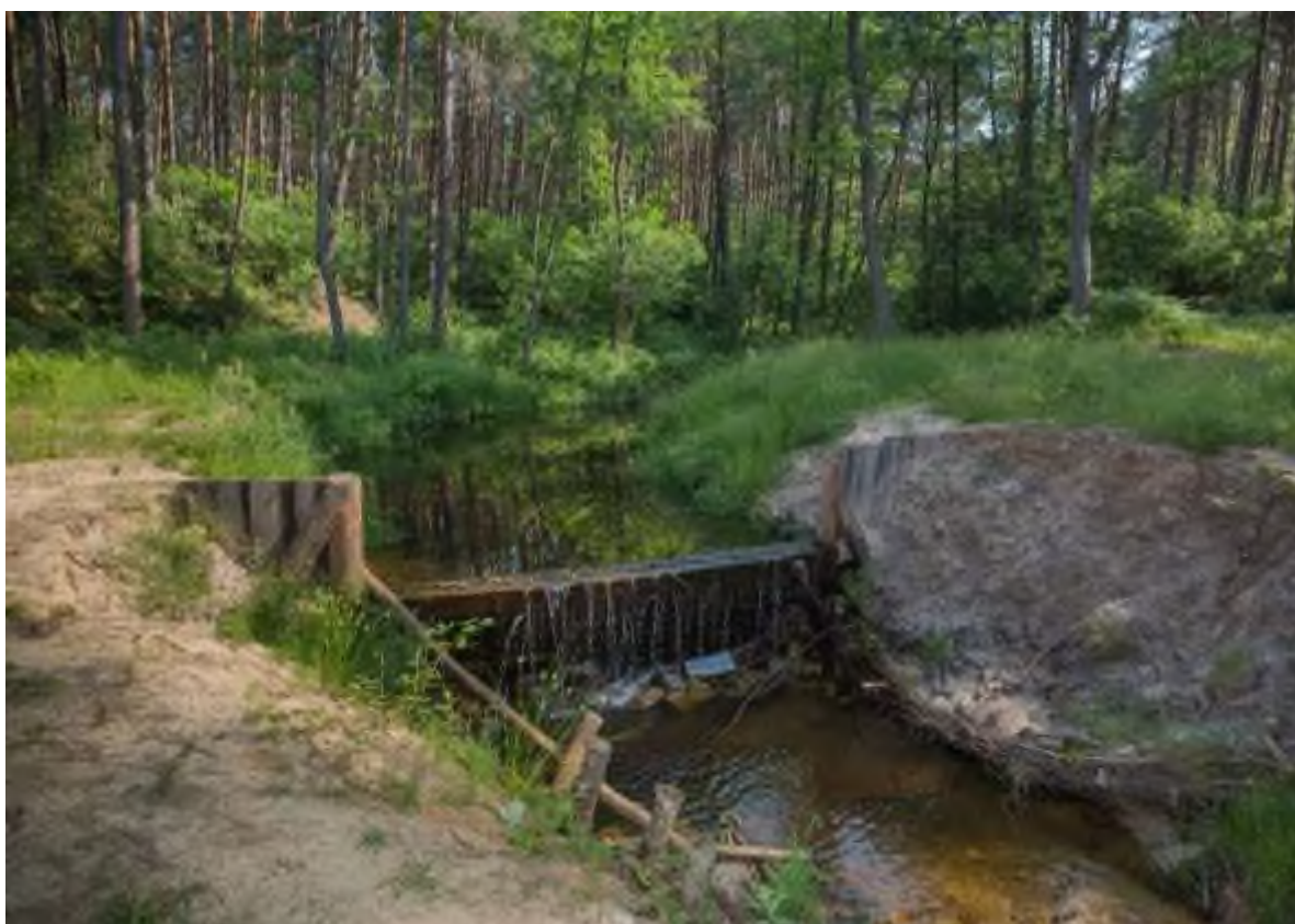
Fotografia 37. Widoczna erozja dna i skarp prowadząca do osłabienia konstrukcji oraz wygięcie progu pod naporem wody, (archiwum CKPŚ.)
