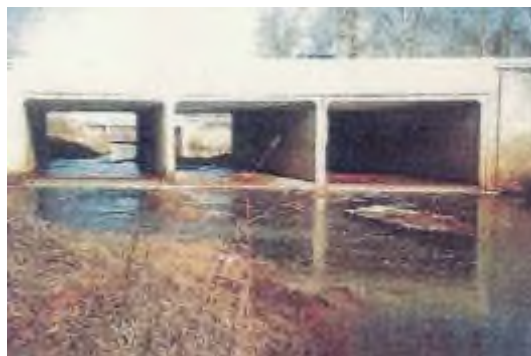
Fotografia 130. Błędnie zaprojektowana rzędna dna ograniczająca migrację ryb podczas niszów [Kosicki 2011].
