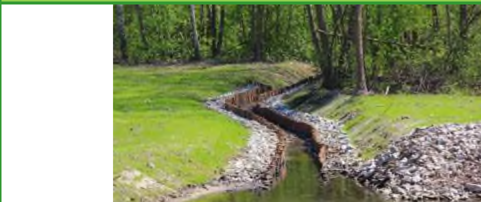
Fotografia 31. Doprowadzalniki wody do zbiorników umocnione narzutem kamiennym i palisadą drewnianą w Nadleśnictwie Syców, 2021 [ https://sycow.poznan.lasy.gov.pl/widget/aktualnosci?p_p_id=101_INSTANCE_sE8O ]
