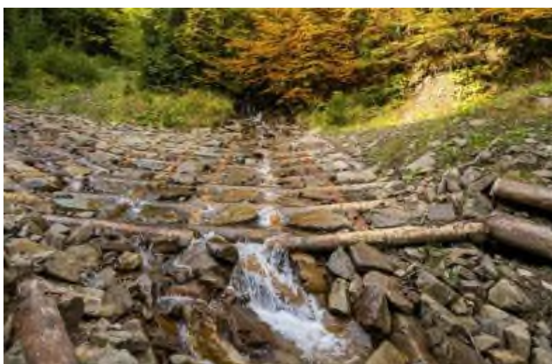
Fotografia 131. Bród drewniano-kamienny koncentrujący wodę pośrodku – Nadleśnictwo Jeleśnia, fot. J. Smarczewski, 2021.
