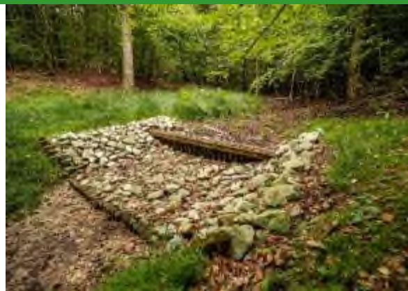
Fotografia 46. Prógi drewniane z umocnieniem kamiennym w Nadleśnictwie Polanów, fot. J. Smarczewski, 2021.
