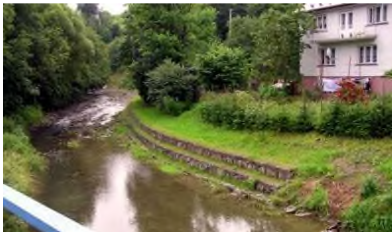
Fotografia 3. Zabezpieczenie brzegu gabionami w celu ochrony zabudowy.
