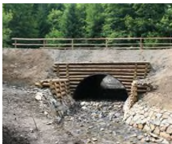
Fotografia 146. i Fotografia 147. Przebudowa przepustu na nowoczesną konstrukcję odporną na zatkanie rumoszem Nadleśnictwa Baligród (archiwum CKPŚ).
