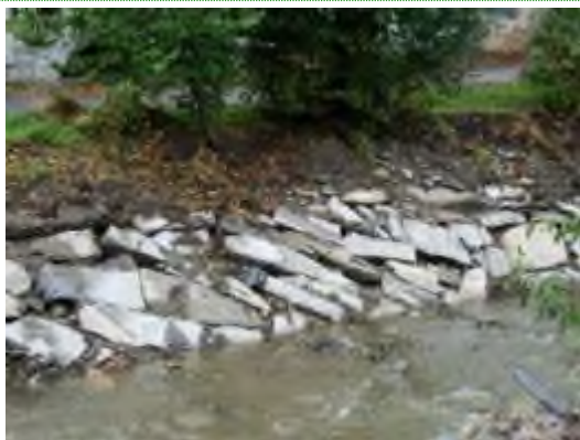
Fotografia 75. Narzut kamienny z dużych głazów układany mechanicznie – Czechy (archiwum CKPŚ).
